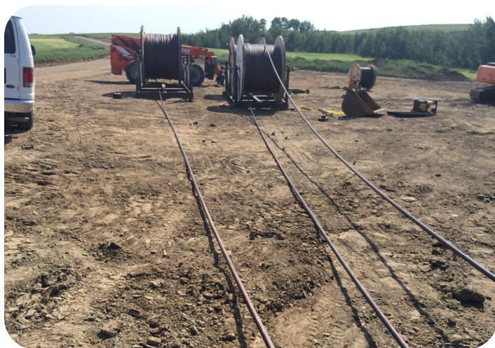
Figures 2-3 : Câbles du réseau collecteur électrique
