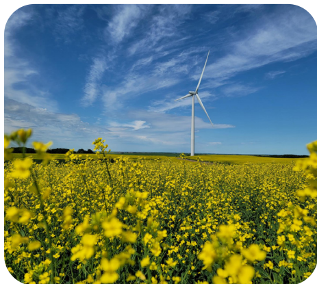
Bull Creek – Projet de 29,2 MW situé dans le district municipal de Provost en Alberta
