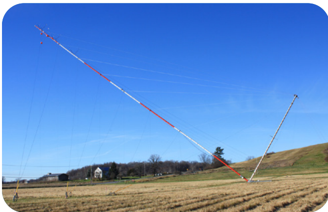
Photo de l'installation d'une tour de mesure
