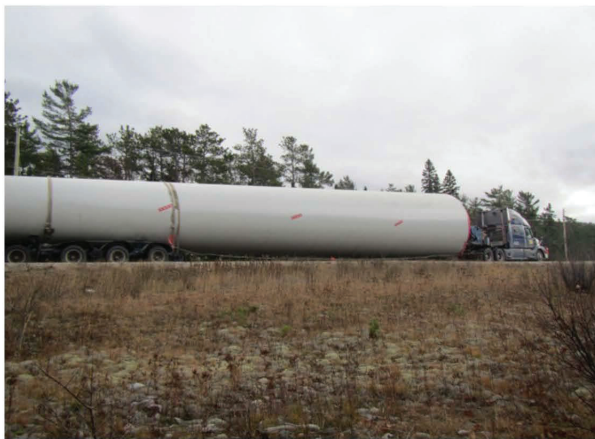
Transport des composants : le mât, la nacelle et les pales sont acheminés sur le chantier de construction.
