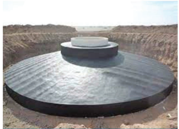
Fondations des éoliennes : les fondations sont construites en béton et armatures d'acier.
