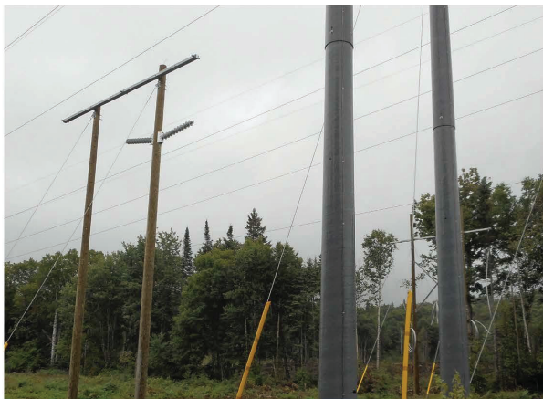
Composantes électriques : la sous-station électrique, le réseau collecteur sont construits et installés.
