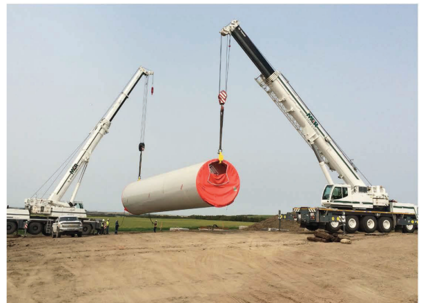
Assemblage des turbines : des grues sont utilisées pour assembler et installer les turbines.
