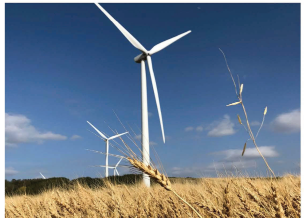
Remise en état : le chantier de construction est démantelé et le site est restauré. La production d'électricité commence.
